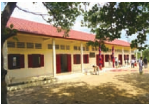
完成した新校舎
