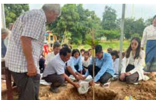
着工式の様子
