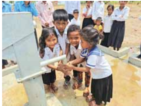
僻村の小さな小学校に井戸が完成
