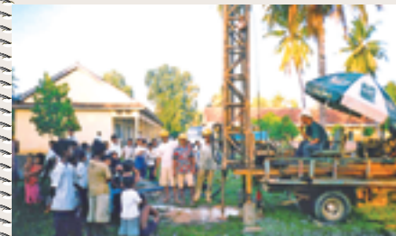
小・中学校や村の広場に井戸建設
