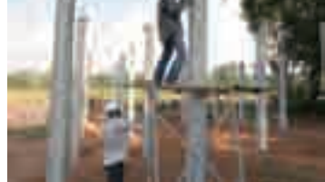
着工したマレッチ小学校新校舎
