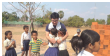
ポーセレイ小学校建設現場で生徒と交流する
